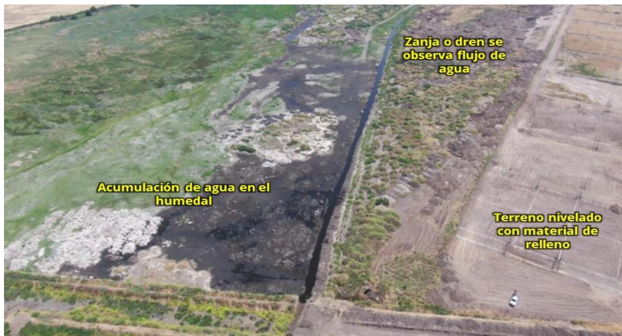
Figura N° 18: Zanja de drenaje en el humedal
