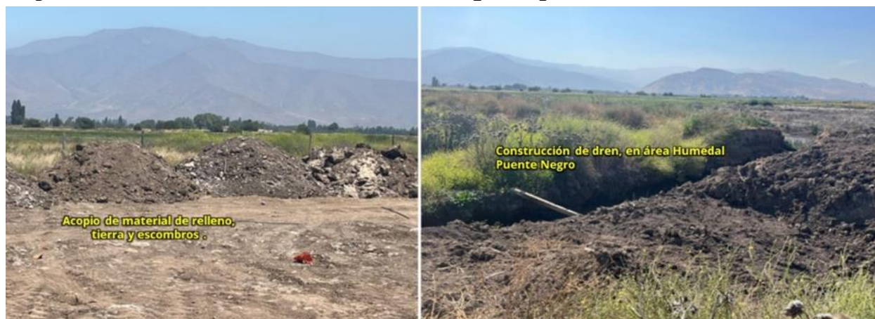
Figura N° 19: Construcción de dren y acopio de material de relleno
