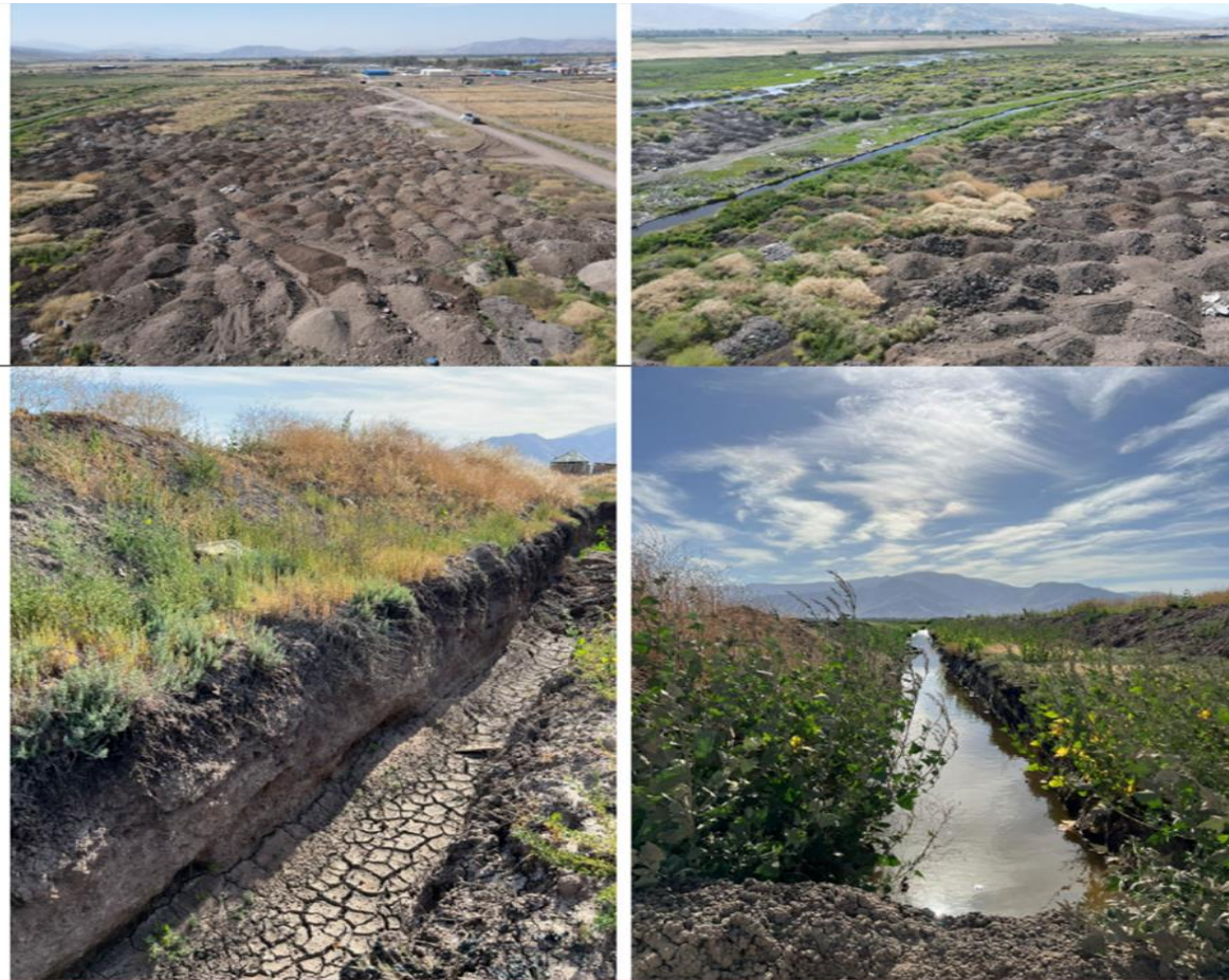
Figura N° 6: Intervención en el área del humedal con zanja de drenaje y depósitos con material de relleno corroborados en terreno
